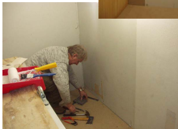
SM6SIM sätter glasfiberväv. Högra bilden: väggarna efter grundmålning
