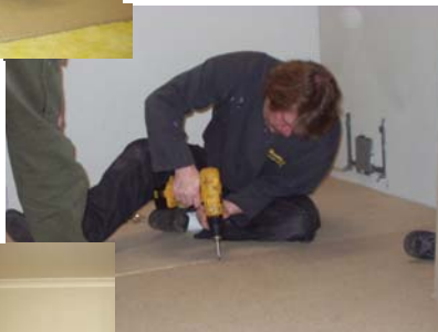
SM6YOF drar de sista skruvarna i golvskiivorna.
